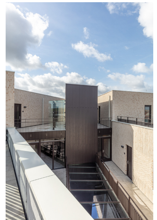
Dakterrassen De Kroon
